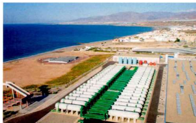
Desaladora Campo de Dalías (Acuamed).
