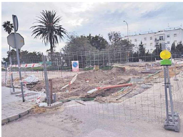
Una imagen actual de los trabajos en la Rotonda de La Puntilla.
