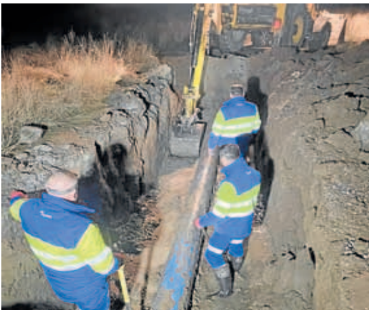
Operarios de Aqualia, durante los trabajos de reparación. AYTO. LA LASTRILLA
