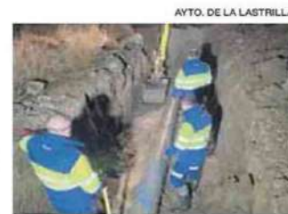
Reparación de la avería.
