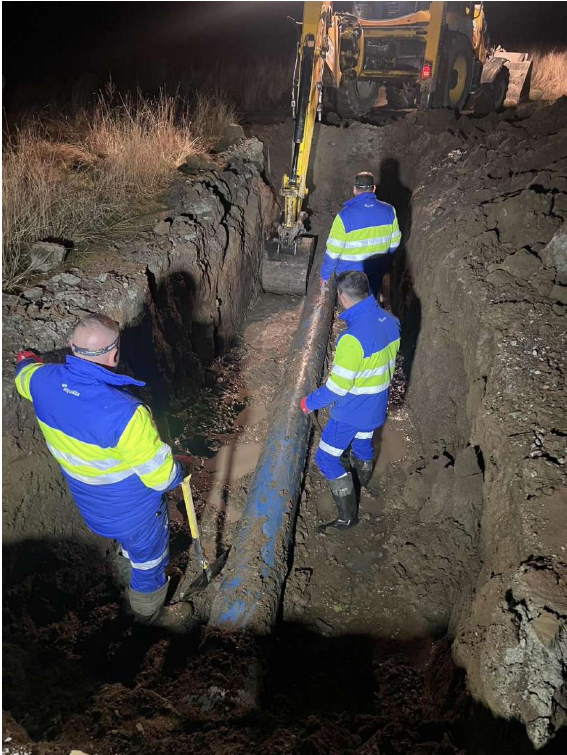
Reparación de la avería / AYTO. DE LA LASTRILLA
