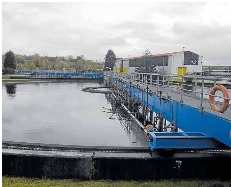
La EDAR de Villaperi trata al año un volumen de agua equivalente a 12.000 piscinas olímpicas. J. C. ROMÁN
